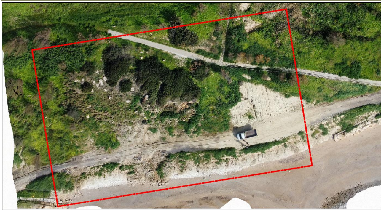
Figura 5 - Area in dissesto (stralcio ortofo da rilievo con SAPR).
