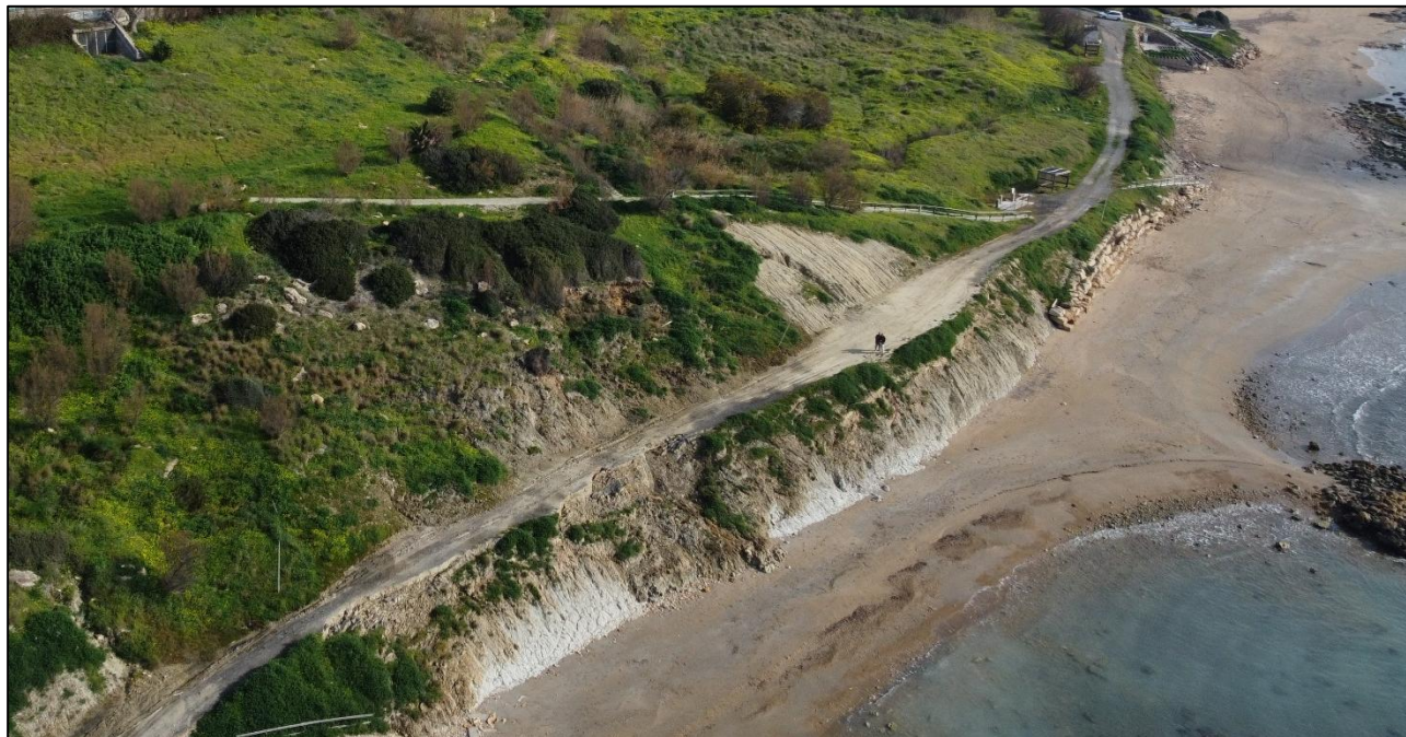
Figura 7 - Area in dissesto (vista da ovest).
